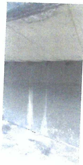
zamakanje po zunanjem zidu lokala
