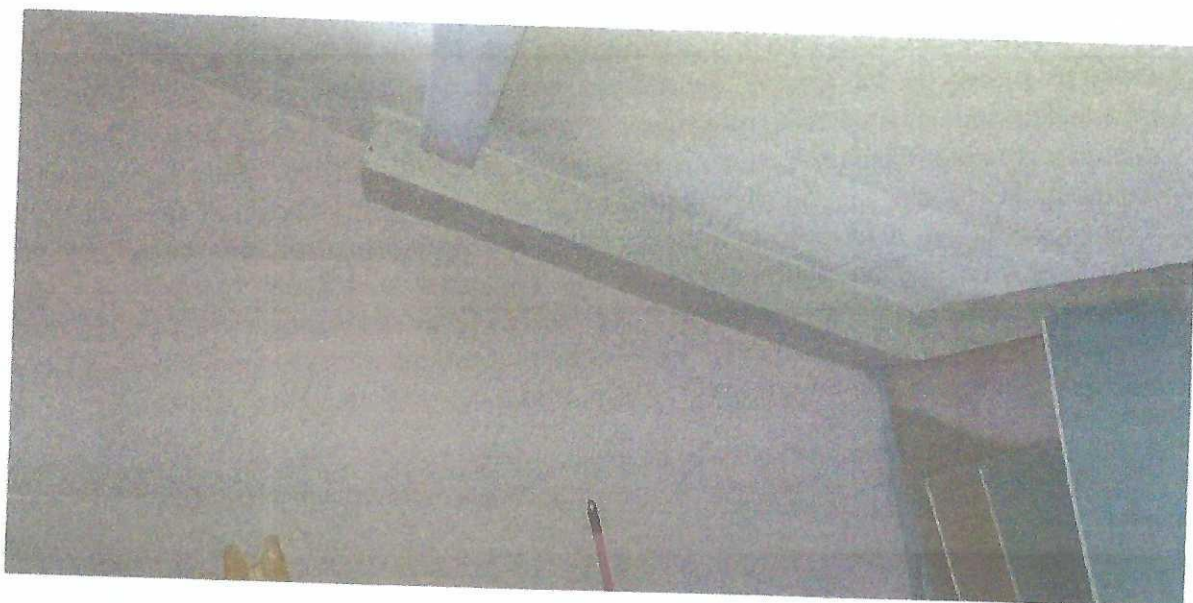
Izvedba kovinskega odvodnega žleba, ki odvaja meteorne vode na prosto
